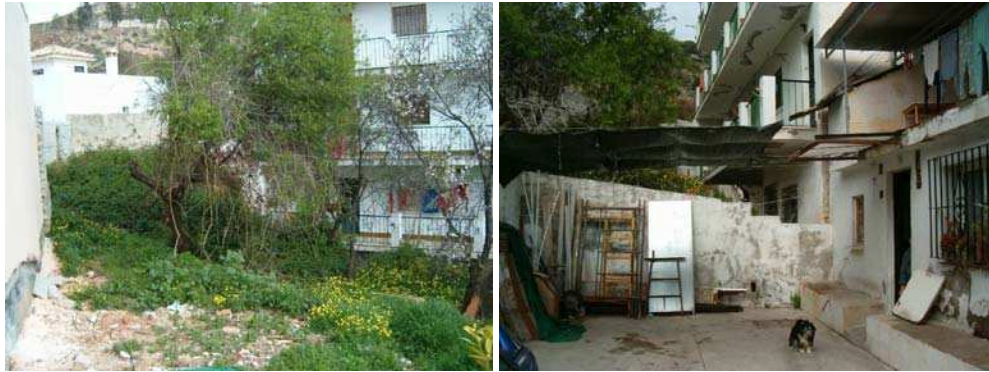
Situaciones de borde urbano
