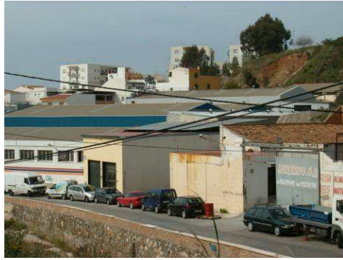
Polígono con viario y accesos insuficiente
